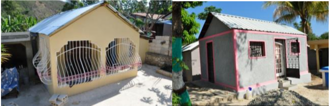
T-shelters modifié en ajoutant des matériaux de construction permanente
