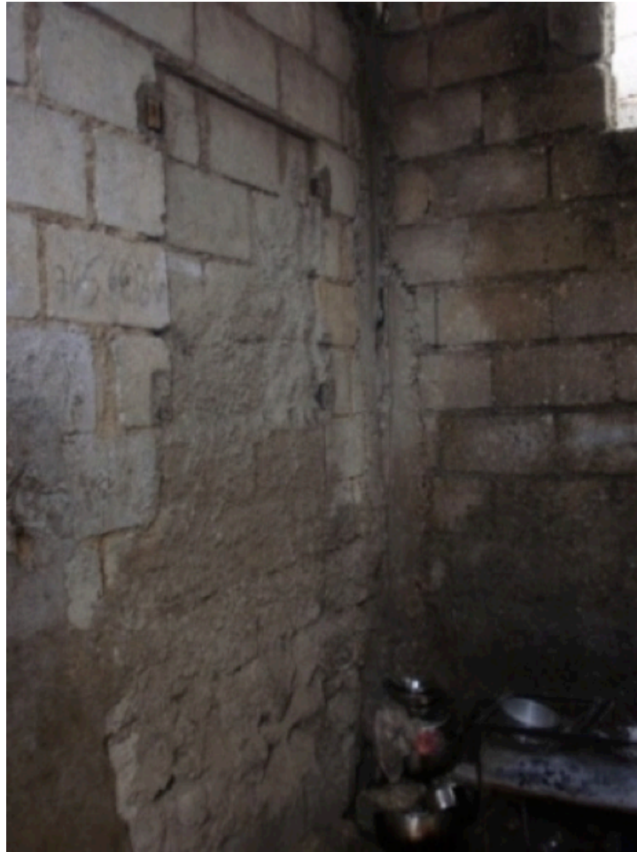
Dessin 43 : Un manque de chaînage vertical
