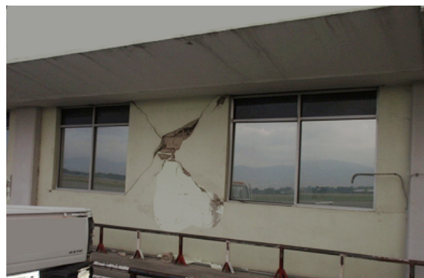
Dessin 7 : Rupture en croix d'un contreventement
