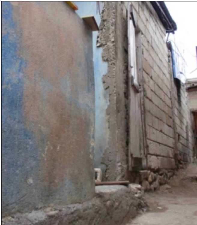
Dessin 47 : Un manque de chaînage bas horizontal
