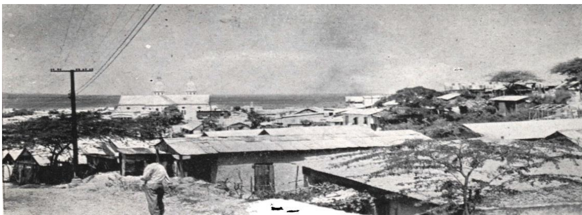
Photo 4 : Quartier de Bel-Air, vue de la route du Fort National en direction de l'Ouest
